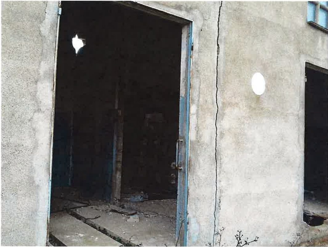
Interior Centre de Transformació
