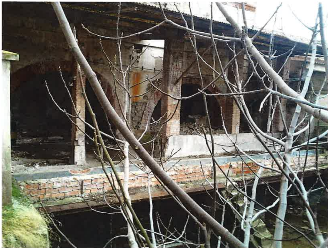
Edifici de Contenció
