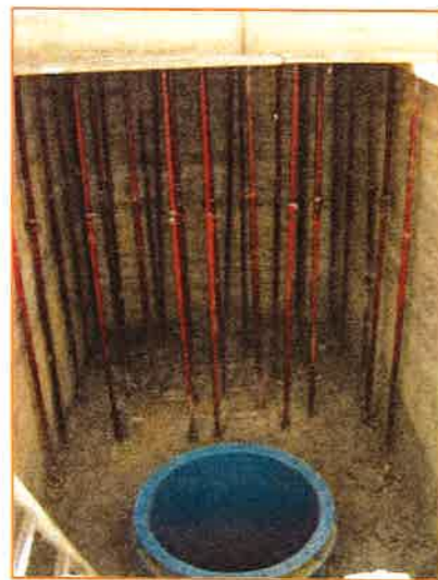
Parte superior de la aspiración antes del montaje de la turbina en la instalación
