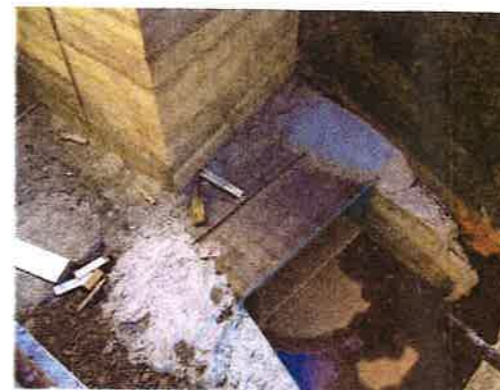
Salida de la aspiración una vez finalizada la obra civil y antes de su puesta en marcha.
